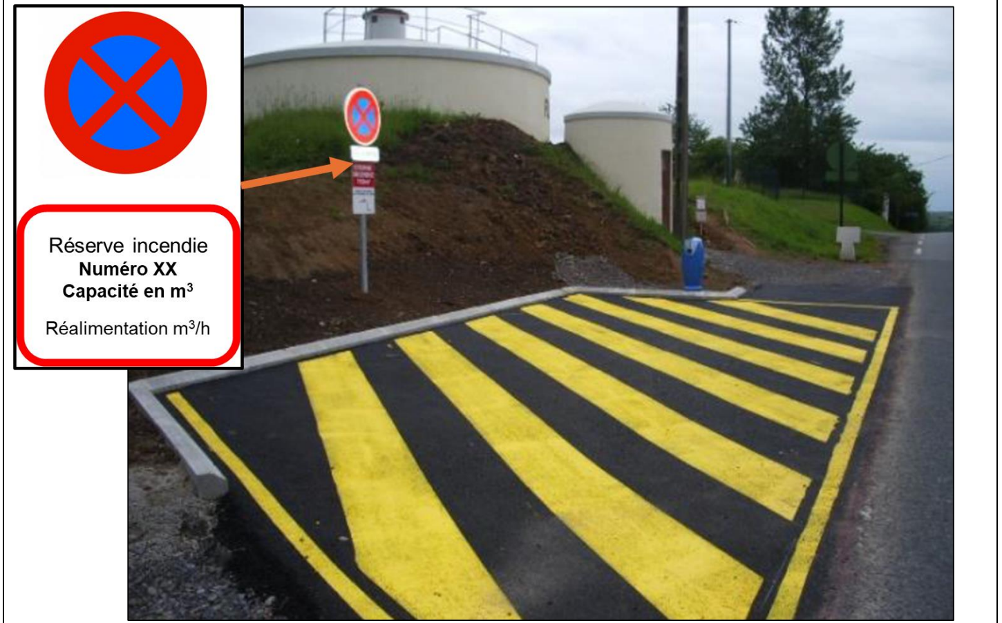
Schémas non contractuels de mise en place de dispositifs et d'aires d'aspiration
